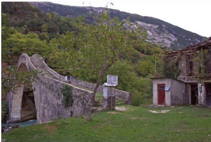
Τελωνειακή διάβαση Γέφυρας Πλάκας Άρτας
