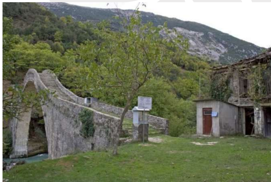
Τελωνειακή διάβαση Γέφυρας Πλάκας Άρτας
